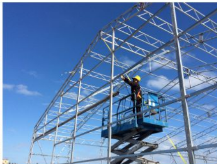
高空組裝作業
