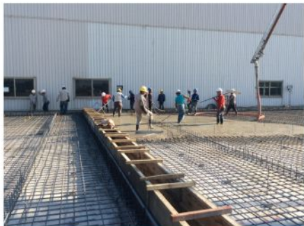
倉庫基座地坪混凝土澆置
